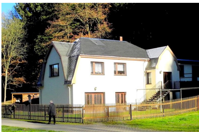
Das Turbinenhaus im Jahre 2016
