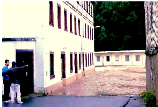
Das Wasser steigt – der Hof ist bereits überflutet
