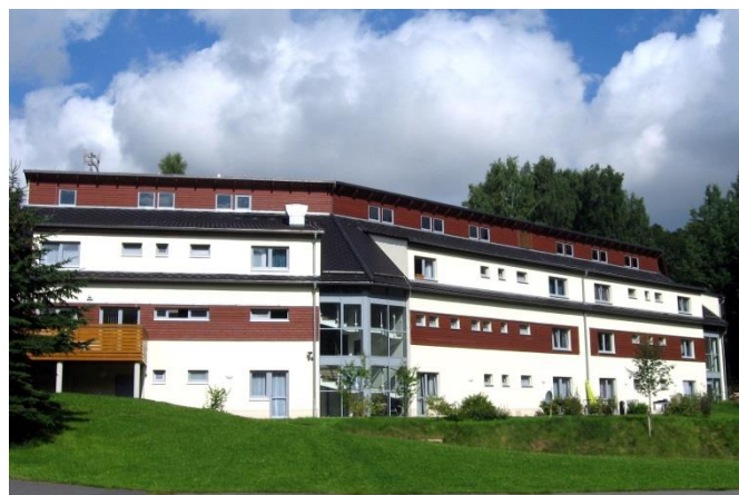
Der Wohnheimneubau im Jahre 2010
