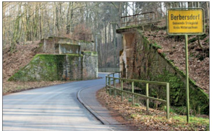
Wegen der langen Sperrung musste ein Notfahrweg für Rettungsfahrzeuge unter Einbeziehung eines Teils der ehemaligen Bahnstrecke sowie der im Oberbau nicht mehr vorhandenen Bahnbrücke im Zuge des Vorhabens mit aufgebaut werden. Diese Aufnahme vom 20. Februar dieses Jahres zeigt die ursprünglich defekte Brücke.
