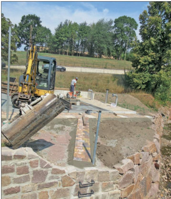
Anfang August 2018 ist die alte Staustelle im Steinbach zurückgebaut. Nach der naturnahen Befestigung der Bachufer wird auf der bereits gefüllten Zisterne an der Aufstellfläche für die Feuerwehr sowie an den umgebenden Außenanlagen gearbeitet.
