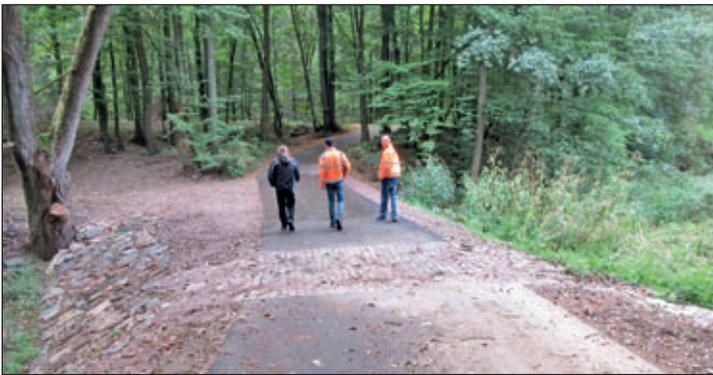
Der Damm zur Rückhaltung von Hochwasser zwischen Arnsdorf und Berbersdorf wurde im Zuge des Bauvorhabens ebenfalls umfassend saniert, sodass er zukünftigen Hochwasserereignissen standhalten wird. Diese Aufnahme entstand bei der Bauabnahme im Oktober dieses Jahres und zeigt die Dammkrone mit befestigter Überlaufrinne.
