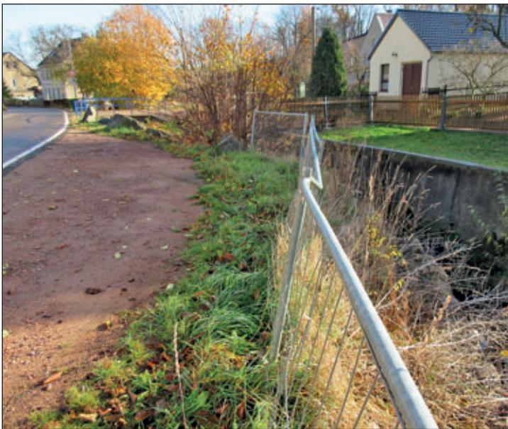
Seit 2013 ist diese marode Stützmauer am Marienbach in Marbach eingestürzt und mit Bauzäunen abgesperrt. Von November 2018 bis Mitte 2019 wird das Bauwerk sowie die anschließende Brücke abgerissen und komplett neu aufgebaut.
