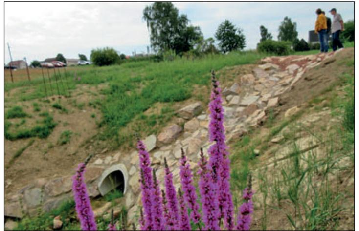
*Die Drosselleitung wurde so bemessen, dass eine rasche Anstauung der Oberflächenwasser vor der Ortslage Marbach gewährleistet ist. Wenn das Becken vollläuft, fließt das Wasser über die hier im Bild zu sehende offene Überlaufrinne, die so ausgebaut ist, dass keine Schädigungen im Dammbereich entstehen.*
