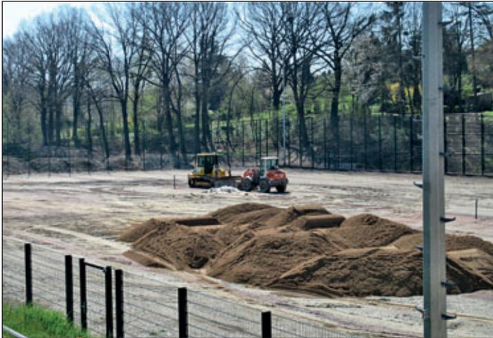
Mitte April 2019 sind alle Begradigungsarbeiten am neuen Sportplatz beendet. Drainagen und die Bewässerungsanlage sind eingebracht. Es beginnt der Aufbau des Untergrundes als Vorbereitung für die Rasenverlegung.
