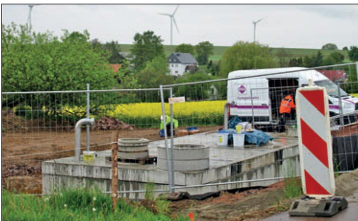
Ende Mai dieses Jahres ist die neue Erdzisterne bereits gesetzt, mit Löschwasser gefüllt und auf Dichtigkeit überprüft, so dass die Verfüllung und die Arbeiten im Oberbereich beginnen konnten.
