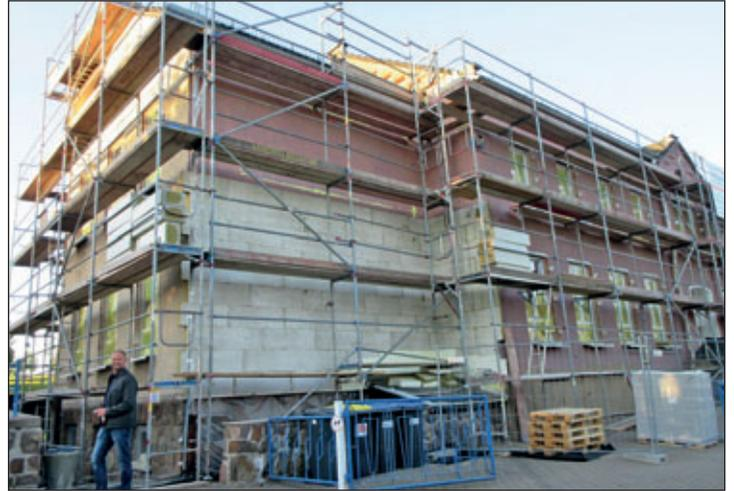
Im Mai 2018 liefen die Arbeiten zur Dämmung der Fassade des Grundschulgebäudes. Damit keine Kältebrücken entstehen, musste die an der Nordseite des Gebäudes befindliche Feuertreppe um rund dreißig Zentimeter vom Gebäude weggerückt werden. Auch dafür wurden neue Fundamente benötigt.
