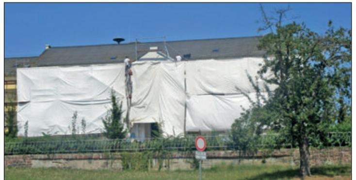
Bei großer sommerlicher Hitze führten Mitarbeiter der Firma Malerwerkstätten Mittweida die abschließenden Arbeiten an der Südseite des Gebäudes in der ersten Augushälfte 2018 aus. Damit dies überhaupt möglich war, mussten die Gerüste komplett verhanden werden. So wurden die Putzarbeiten trotz der großen Sonneneinstrahlung möglich.
