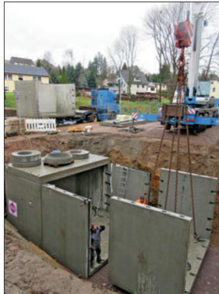
*Nach Abschluss der Abbruch- und Erdarbeiten sowie der Herstellung des Planums wird hier am 28. November 2017 mit schwerer Krantechnik die neue Zisterne in ihren Einzelteilen in die Erde eingelassen.*
