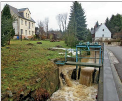
*Derartige Staustellen wurden zu DDR-Zeiten oftmals zur Sicherung der Löschwasserversorgung in den Dorfbächen der Region aufgebaut. Der weitere dauerhafte Betrieb dieser Einrichtungen ist aufgrund der heutigen Rechtslage nicht mehr genehmigungsfähig, da damit die Durchgängigkeit der Fließgewässer nicht gegeben ist. Unsere Aufnahme vom 21. Februar 2017 zeigt die Staustelle an der Talstraße 41 in Berbersdorf und ihre Funktionseinheit vor dem Rückbau.*
