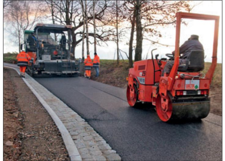
Ende November 2017 konnten die Bitumenarbeiten mit dem Aufbringen der Trag- und Deckschicht erfolgen, nachdem in den Monaten zuvor die Straßenborde, Einläufe und Schnittgrinne mit Natursteinen gesetzt wurden.
