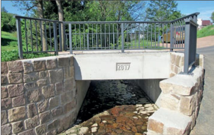
Die neue Brücke über den Steinbach trägt zukünftig eine Achslast von 40 Tonnen und stellt mit ihrer massiven Bauweise eine sichere Zufahrt für die anliegenden Grundstücke in den nächsten Jahrzehnten dar.
