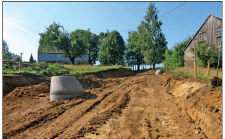
Zunächst wurden Betonrohre zur Straßenoberflächenentwässerung und Leitungen der zentralen Trinkwasserver- und Abwasserentsorgung verlegt. In diesem Zuge konnte erreicht werden, dass auch Energieversorgungs- und Telekommunikationsleitungen durch zusätzliche Aufträge der diese Netze betreibenden Unternehmen mitverlegt wurden und damit die bisherigen Oberleitungen entfallen. Diese Aufnahme zeigt das Ausmaß der Erdarbeiten.
