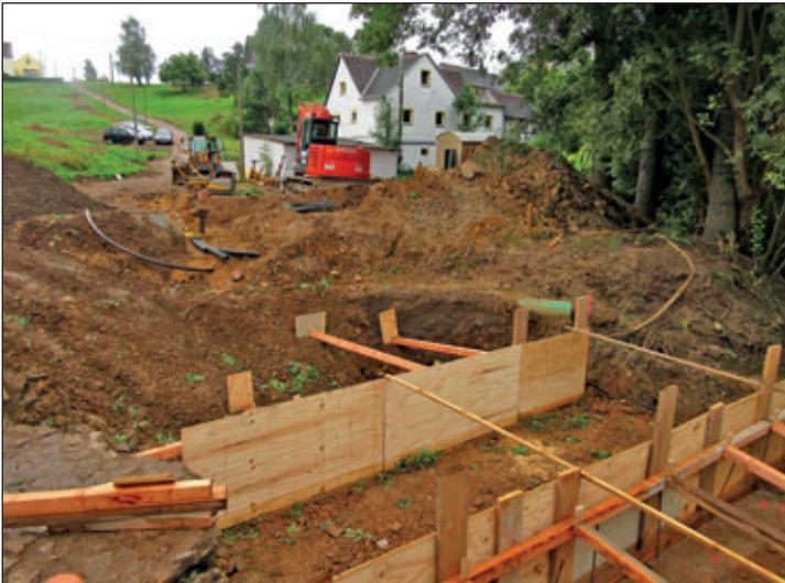
Mitte September 2017 ist die alte Brücke über den Steinbach abgerissen und die Schalungen stehen für den Aufbau des neuen Brückenbauwerkes.
