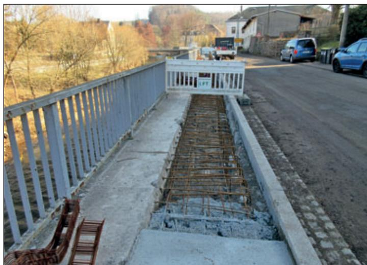
*Derzeit wird an den Fußwegen an der Straße der Einheit gearbeitet. Unsere Aufnahme zeigt die aus statischen Gründen notwendigen Stahlgeflechtarbeiten zur Verankerung der Stützmauer zur Striegis mit dem Straßenkörper.*
