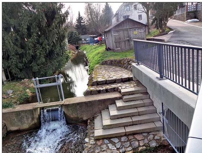
*Um die Durchgängigkeit des Hirschbaches in Pappendorf wieder herzustellen, wird diese Staustelle im Frühjahr dieses Jahres zurückgebaut. Die daneben befindliche Garage wird abgerissen und an dieser Stelle eine unterirdische Löschwasserzisterne eingebaut.*
