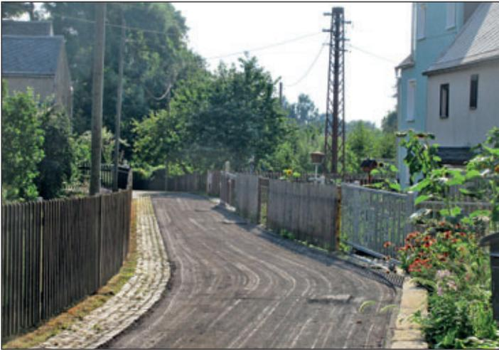
Gleich an mehreren Straßenabschnitten konnte im letzten Jahr die Straße am Etzdorfer Steinbach aufgewertet werden. Unser Bild zeigt einen Teilbereich des „Dornröschenweges“ im August letzten Jahres, bei dem die Bitumendecke abgefräst und neu aufgebracht wurde.
