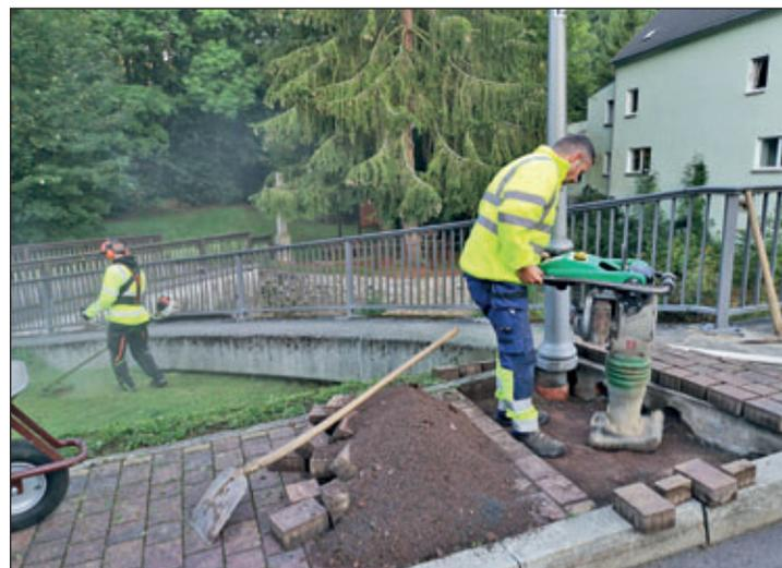
Auch gepflasterte Flächen um Straßeneinläufe, sowie Schnittgerinne, Regenwasserabschläge, Einfassungen oder Fußwege müssen durch den Bauhof repariert werden. Hier wird der abgesenkte Bereich des Fußweges an der Brücke über die Striegis im Striegiszusammenfluss angehoben.
