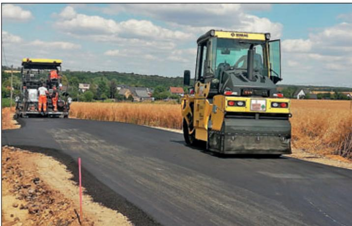
*Nach Abtrag des Altbitumens wurde zunächst eine Bodenstabilisierung ausgeführt, auf der die bituminöse Trag- und Deckschicht aufgebracht werden konnte. Diese Aufnahme zeigt Mitarbeiter der Firma Walter Strassenbau KG aus Etzdorf bei der Arbeit zum Aufbringen der Deckschicht.*
