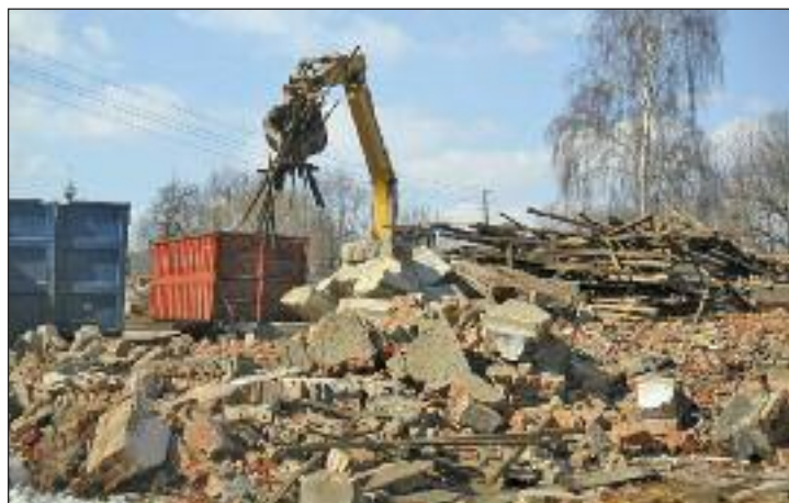
Im Frühjahr 2006 rückten die Abrissbagger an und beseitigten die gesamten baulichen Anlagen vollständig.
