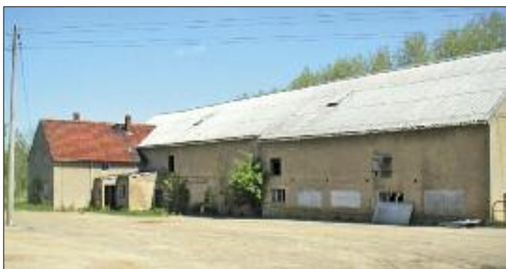
Auch diese Aufnahme zeigt einen weiteren Gebäudekomplex an diesem Standort vor seinem Abriss.
