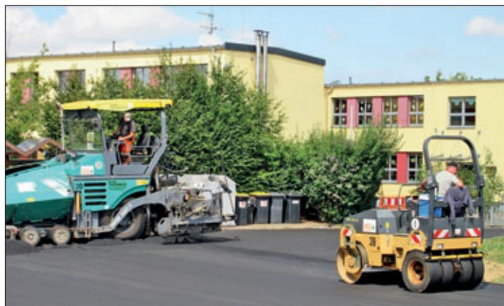
Diese Aufnahme entstand am 16. August letzten Jahres und zeigt Arbeiten zum Einbau der bituminösen Deckschicht durch Mitarbeiter der Firma Walter Straßenbau KG aus Etzdorf.
