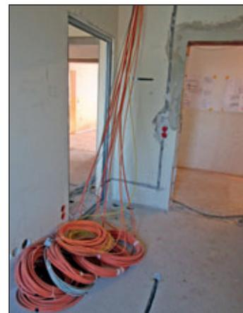
Neben Elektroleitungen, wurden auch Kabel für die Brandschutz-, die Telefon- und die Sicherheitsanlagen neu verlegt. Die Mitarbeiter der Firma Elektro Roßwein hatten mit dem hohen Materialeinsatz alle Hände voll zu tun.
