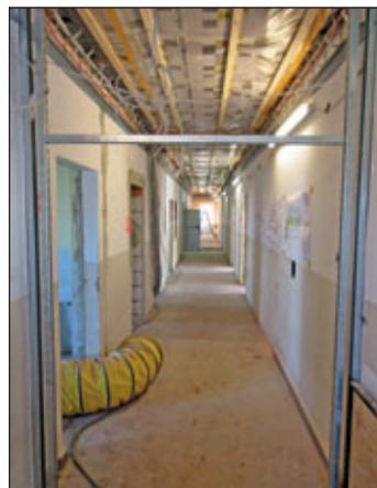
Das Gebäude wurde im Inneren vollständig entkernt, da so ziemlich alle Ver- und Entsorgungsleitungen einschließlich der Elektroanlage komplett erneuert wurden. Dieses Bild zeigt den freigeräumten Flur im Obergeschoss der Kindertagesstätte.
