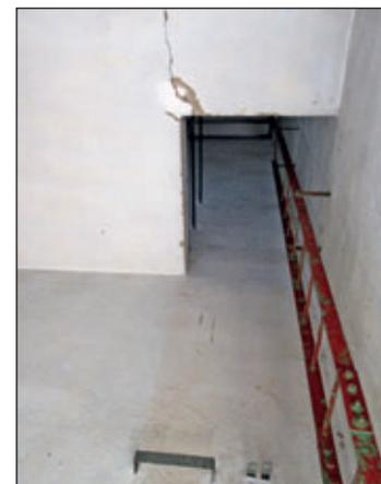
Diese Aufnahmen gewähren noch einmal historische Blicke in das Innere der alten Turmstationen. Über den direkt hinter dem Eingang befindlichen Schaltanlagen mussten die Mitarbeiter des Energieversorgungsunternehmens über Leitern in die oberen Ebenen steigen, um zu den Hausanschlüssen zu gelangen.
