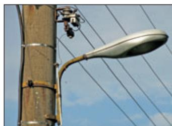
Wohl alle in der DDR-Zeit hergestellten Leuchtentypen waren bis Ende 2019 in Dittersdorf in Betrieb. Es war stets eine Herausforderung bei Reparaturarbeiten, die entsprechenden Teile für den Einbau zum Weiterbetrieb der Altanlage zu finden. Dieses Bild zeigt exemplarisch eine dieser historischen Lampen.
