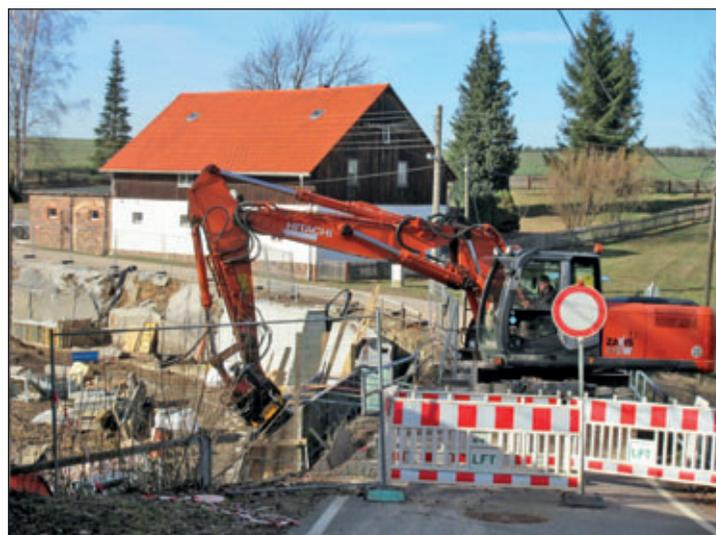
Im Frühjahr letzten Jahres wurde die marode Teichmauer abgerissen und mittels Betonschalung die neue Stützmauer errichtet.
