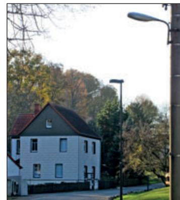
Anfang November 2019 sind erste Masten der neuen Anlage gestellt und Lampen montiert. Unsere Aufnahme zeigt den Unterschied von alt auf neu. Besonders problematisch bei der Altanlage waren die vielen Holzmasten, die aufgrund ihres jahrzehntelangen Alters stark verwittert, teilweise aufgerissen und morsch waren, sodass ein Umstürzen nicht ausgeschlossen werden konnte. Diese Gefahr wurde mit der Umsetzung der Baumaßnahme beseitigt.
