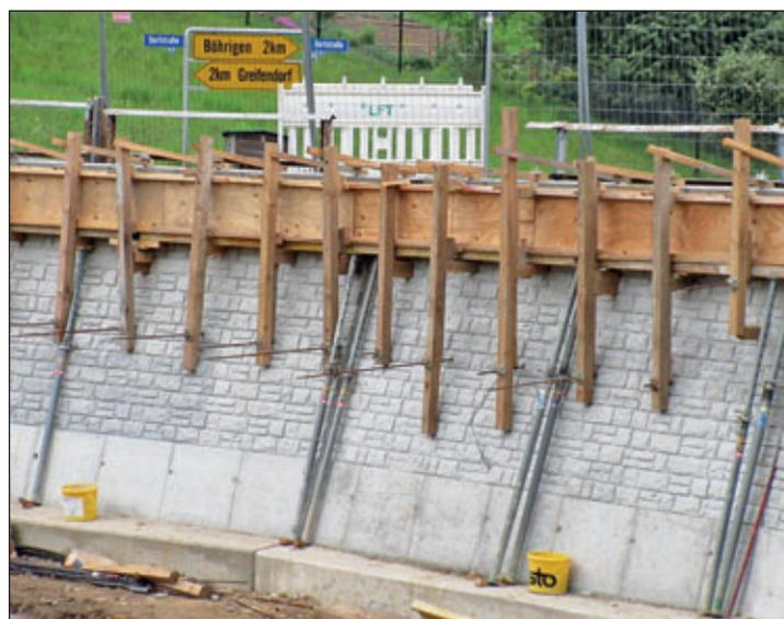
Hier erfolgen Schalungsarbeiten an der Stützmauer, die durch eine Schablone die Optik einer gesetzten Steinmauer erhielt.
