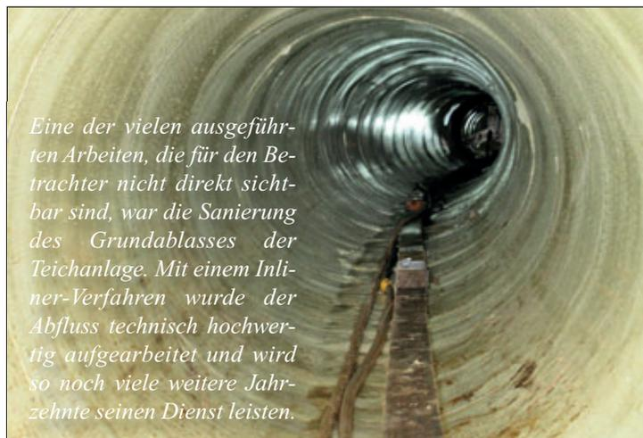
Eine der vielen ausgeführten Arbeiten, die für den Betrachter nicht direkt sichtbar sind, war die Sanierung des Grundablasses der Teichanlage. Mit einem Inliner-Verfahren wurde der Abfluss technisch hochwertig aufgearbeitet und wird so noch viele weitere Jahrzehnte seinen Dienst leisten.
