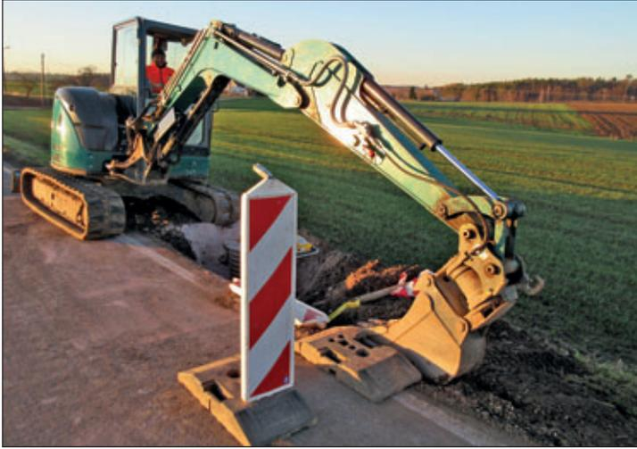
*Gegenstand des Bauvorhabens war auch die in einigen Teilen notwendige Verlegung neuer Erdkabel für die Beleuchtungsanlage. Diese Arbeiten wurden vom Baubetrieb LFT Ostrau ausgeführt. Dieses Bild entstand am 4. Dezember letzten Jahres bei der Kabelverlegung in Richtung Greifendorf.*
