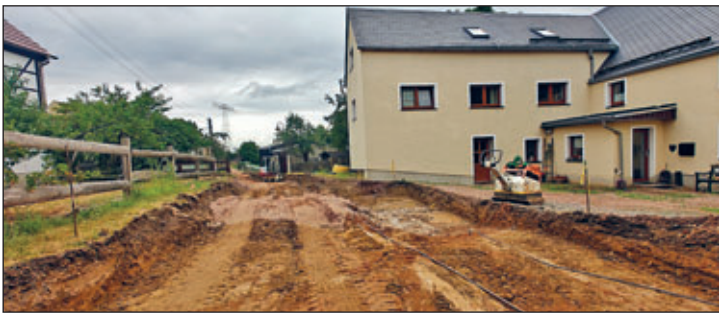
Diese Aufnahme vom 18. August 2026 zeigt einen der grundhaft ausgebauten Bereiche vor dem Einbau der Schotterlage zur Herstellung der Tragfähigkeit.
