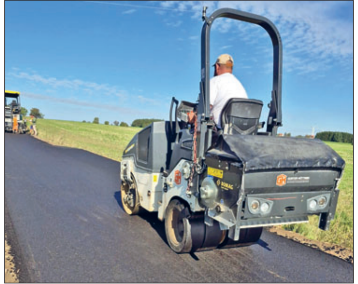
Im September 2026 wird hier am Aufbringen der bituminösen Schichten durch das beauftragte Unternehmen, die Firma Gunter Hüttner aus Chemnitz, gearbeitet.
