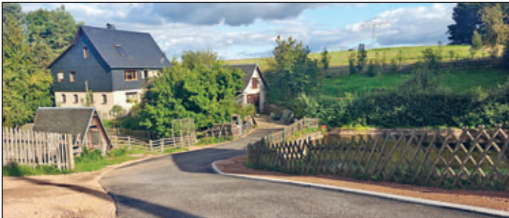
Im Zuge der Baumaßnahme konnte der Abfluss und Notüberlauf des unteren Kaltofener Teiches an der Dorfstraße, der früher auch als Freibad genutzt wurde, erneuert werden. Anschließend wurde die bisher aus Granitpflaster bestehende und stark verformte Zufahrt zum Wohngrundstück Kaltofen Nr. 20 neu bituminös ausgebaut.
