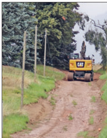
Diese Aufnahme zeigt erste Arbeiten zur Wiederherstellung des Straßenuntergrundes im Sommer des Jahres 2025.
