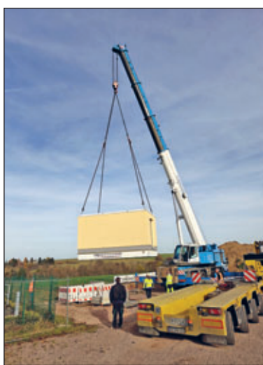
Diese Aufnahme zeigt die Anlieferung und den Einbau eines Gebäudes für die zentrale Technik des zukünftigen Breitbandnetzes in Striegistal am Nordrand des Gewerbegebietes in Berbersdorf.
