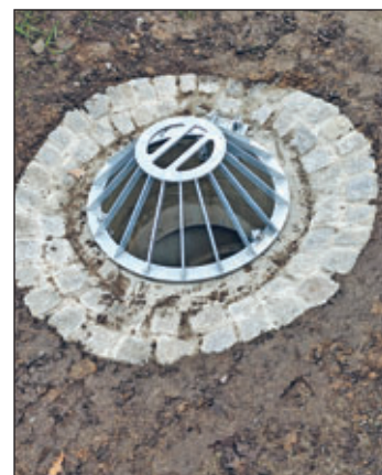
Diese Aufnahme zeigt das angelegte Becken, welches verhindern soll, dass die in den letzten Jahrzehnten aufgetretenen ungünstigen Sedimentaufräge auf die Marbacher Straße zukünftig möglichst vollständig verhindert werden.
