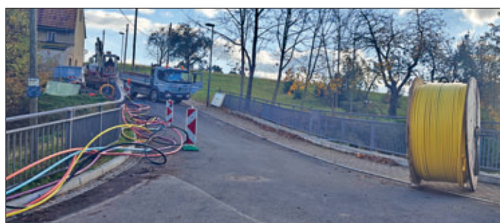
An vielen Stellen erfolgt gleichzeitig die Verlegung von Breitbandleerrohren als Vorbereitung für die zukünftige Einblasung von Glasfaserleitungen im Gemeindegebiet. Die Aufnahme links unten zeigt eine Baustrecke von Pappendorf in Richtung Goßberg, auf der sowohl das Netz von Reichenbach, Stadt Großschirma bis nach Pappendorf ankommt, als auch eine Rückführung vom Technikgebäude an der Schulstraße bis nach Goßberg und zum Lichtenstein auf dieser Strecke erfolgt. Oben zu sehen sind zum Einbau vorbereitete Leerrohre in der Ortslage Dittersdorf.
