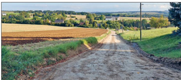
Diese Aufnahme zeigt den Abschluss der Arbeiten zur Beseitigung der Schäden aufgrund eines Starkregeneignisses.
