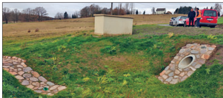
Diese Aufnahme zeigt das angelegte Becken, welches verhindern soll, dass die in den letzten Jahrzehnten aufgetretenen ungünstigen Sedimentaufräge auf die Marbacher Straße zukünftig möglichst vollständig verhindert werden.
