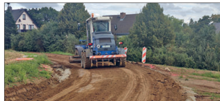
Es erfolgte eine Bodenstabilisierung mit Beimischung von Kalk- und Zementanteilen, die zu einem frostsicheren Aufbau des Straßenuntergrundes beiträgt.
