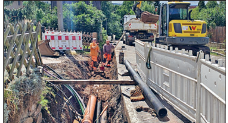
Mitarbeiter der Firma Gunter Hüttner aus Chemnitz verlegen im Sommer 2025 Breitbandlerrohre und weitere Medien am Goßberger Berg.
