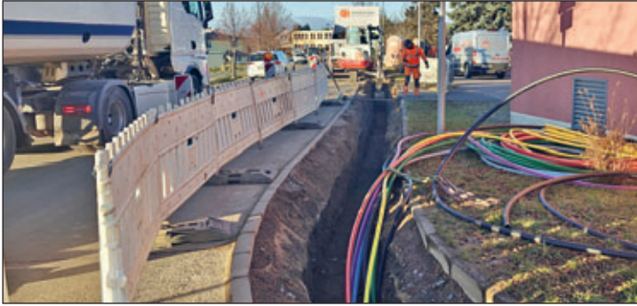
Diese Aufnahme zeigt im November 2025 eine Baustelle der Firma Gunter Hüttner Chemnitz am Abzweig Richard-Witzsch-Straße in Pappendorf am Abzweig Goßberg zur Verlegung von Leerrohren für den Breitbandausbau.
