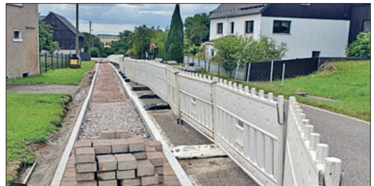
Ende August 2025 sind die Granitborde zur Abtrennung der Gehweganlage zur Kreisstraße K 8217 gesetzt und die Pflasterung des Gehweges hat bereits begonnen.
