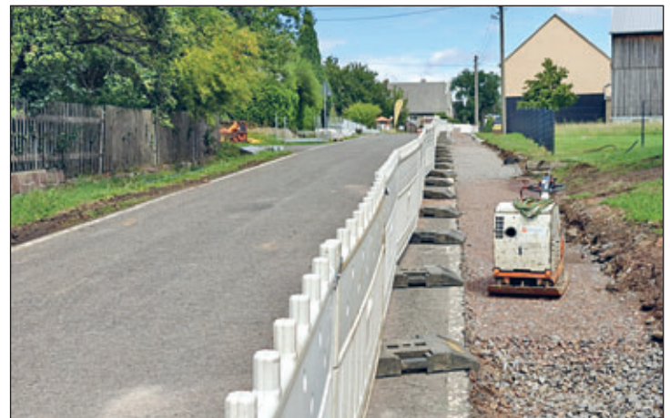
Nach Abschluss der Medienverlegung erfolgte der frostsichere Ausbau der Gehweganlage.
