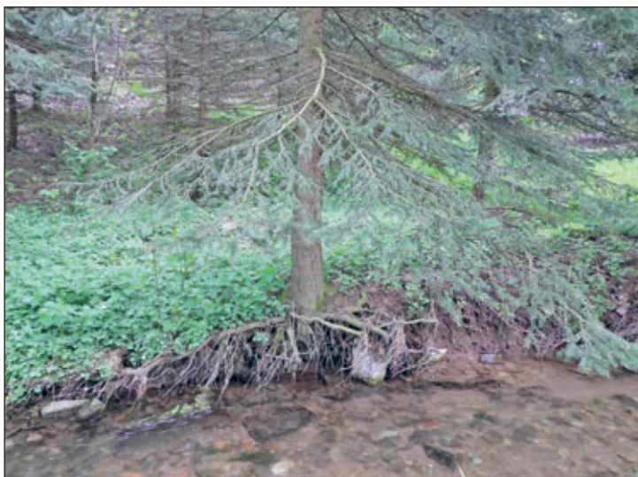
Fichten als Flachwurzler werden schnell unterspült und die Wurzeln bieten dem Ufer keinerlei Halt. Foto: Landratsamt Mittelsachsen
