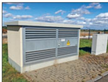
Hier zu sehen sind die zentrale Gashochdruck- und die Mittelspannungsstation für Elektroenergie für das Gewerbegebiet.
