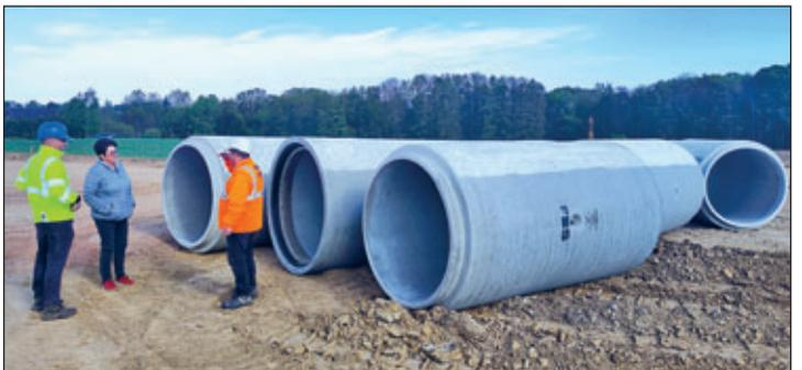
Von diesem größten Regenrückhaltebecken im Striegistaler Industrie- und Gewerbegebiet aus wurden Ablaufleitungen verlegt, deren Dimensionierung hier gut zu sehen ist.
