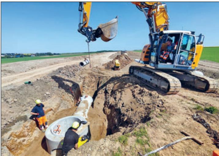
*Im April 2024 laufen die Arbeiten zur Errichtung einer Planstraße D. Hier zu sehen ist der Einbau von Rohrleitungen zur Abführung von Oberflächenwasser von der Straße und von den Gehwegen, durch Mitarbeiter der Firma Walter Straßenbau KG aus Etzdorf.*
