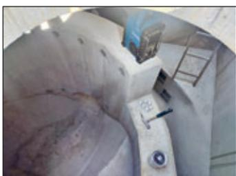
Diese Aufnahme gewährt einen Einblick in einen sogenannten Drosselschacht, mit dem die Energie des Wasserlaufs gebrochen wird und der gleichzeitig dem Zweck der Regulierung des Abflusses in den Schmalbach dient.
