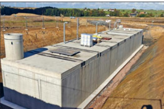
Diese Aufnahme entstand bei der Errichtung dieser Löschwasserzisterne und zeigt, welches große Bauwerk unterirdisch eingebaut ist.
