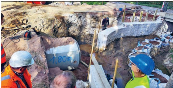
Zwischen dem Ein- und Auslaufbauwerk verläuft der Kanal auf einer Strecke von rund 180 Metern und hat eine Dimension von 1,80 Meter. Hier ist der Bau am Auslaufbauwerk oberhalb der Brücke zwischen Schmalbach und Berbersdorf zu sehen.
