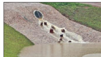
Hier zu sehen ist einer von zwei Zuläufen zum Regenrückhaltebecken R1. Links im Trockenzustand und rechts mit einlaufendem Oberflächenwasser.
