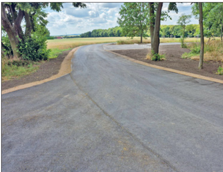
Diese Aufnahme zeigt die instand gesetzte Straße zu den Vier Linden in Etdorf im August dieses Jahres.
