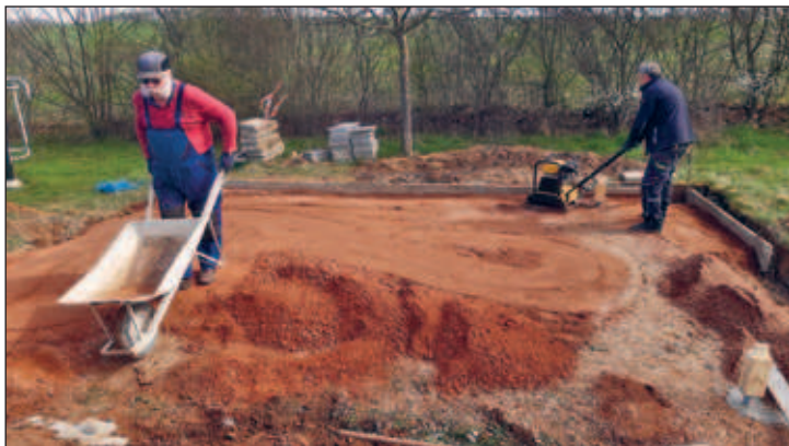
Bau der Fundamente für die Schach- und Bühnenhütte
