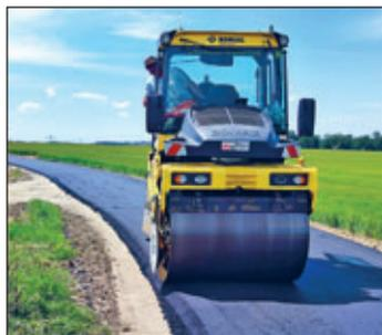
Im Juni dieses Jahres erfolgte der Einbau der bituminösen Schichten durch Mitarbeiter der Firma Walter Straßenbau KG aus Etzdorf.
