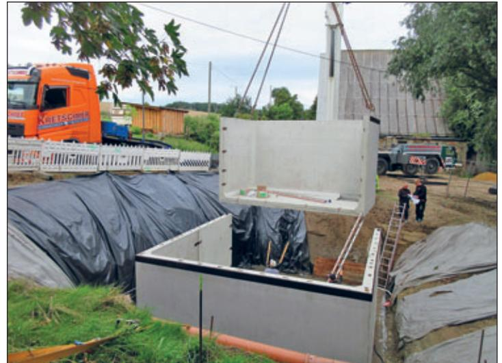
Am 8. August 2023 erfolgte mittels schwerer Krantechnik der Einbau der einzelnen Teile für die Zusammensetzung der Betonzisterne in der Ortsmitte von Kummersheim.
