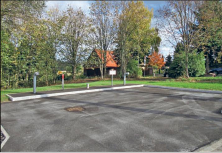
Im November dieses Jahres ist die Zisterne mit frischem Löschwasser befüllt, was mit der von außen erkennbaren Füllstandsanzeige nachgewiesen wird. Die Aufstellfläche für die Feuerwehr ist hergestellt und wurde so gebaut, dass ein Anfahren an die Entnahmestutzen verhindert wird.
