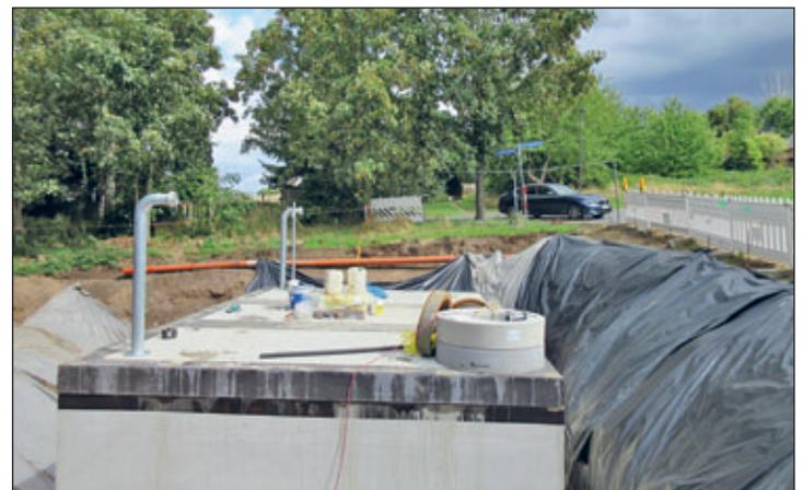
Bereits einen Tag darauf ist der Betonkörper einschließlich seiner Decke fertiggestellt und die Verfüllung sowie die Einbringung von Drainagen als Aufschwemmschutz kann beginnen.
