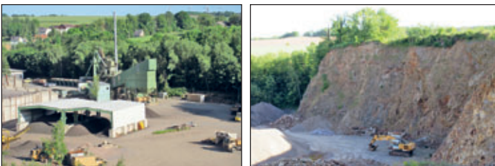
Diese beiden Bilder zeigen die Bitumenmischanlage, das Verwaltungs- und Werkstattgebäude sowie Materiallagerplätze und rechts eine Abbaumwand im Steinbruch der Firma Walter Straßenbau KG in Etzdorf.
