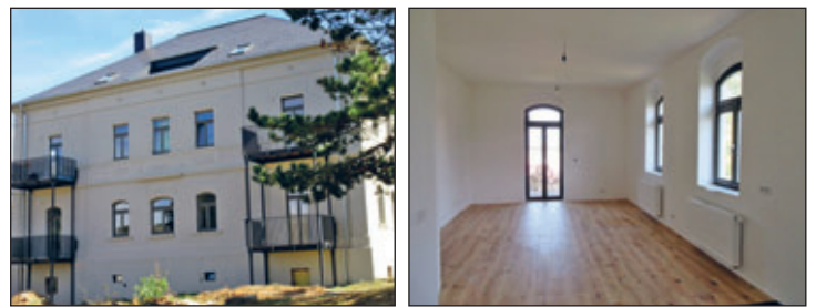
Es entstanden fünf Mietwohnungen mit Balkonen, die mit modernem Standard ausgestattet sind und nunmehr zur Anmietung zur Verfügung stehen.
