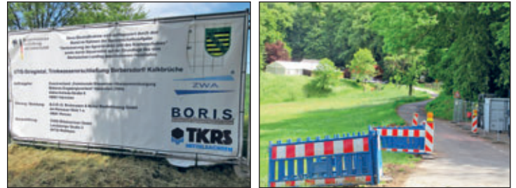
Dabei entstanden diese beiden Fotos und dokumentieren auszugsweise die umfangreichen Bauvorhaben die hier zum Anschluss der Ausflugsraststätte „Waldhaus“ Kalkbrüche in Kaltofen führen.
