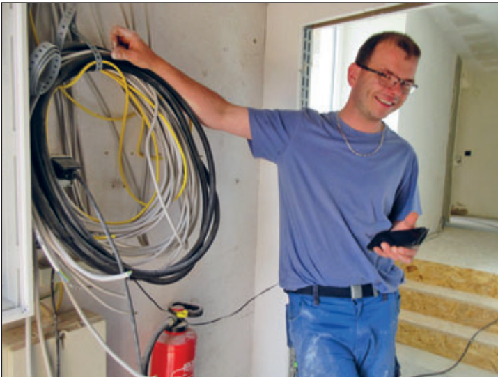
Unsere Aufnahme vom 8. Juni 2023 zeigt Elektromeister Denis Koppe aus Etzdorf bei Elektroarbeiten.
