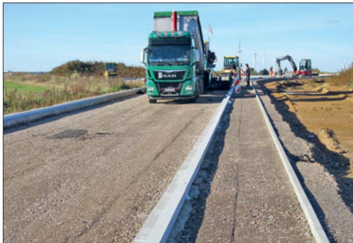
*Nach dem Abschluss der Arbeiten im Untergrund konnte das Planum der neuen Erschließungsstraße aufgebaut werden. Ende September dieses Jahres steht der Unterbau.*
