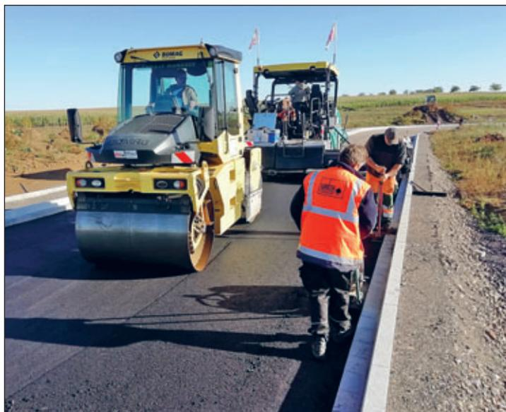
*Die bituminösen Schichten wurden in den Erschließungsstraßen in drei Lagen eingebaut. Hier erfolgte Anfang Oktober dieses Jahres der Einbau der ersten Tragschicht.*
