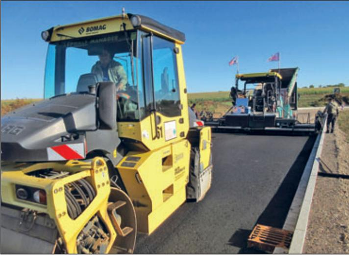
In den darauffolgenden Tagen wurde die Binder- und Deckschicht auf der neuen Fahrbahn aufgebracht. Mit einer Gesamtdicke von 30 Zentimetern wurde eine langhaltbare Lösung für die Erschließungsstraße geschaffen.
