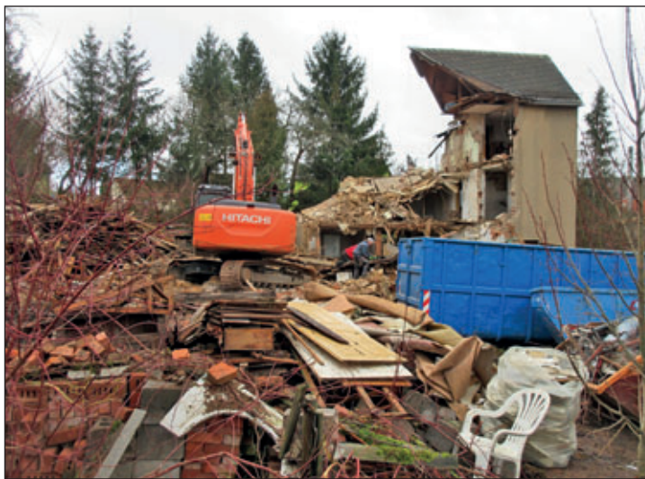
Im Februar 2022 waren die Abrissarbeiten bereits in vollem Gang.
