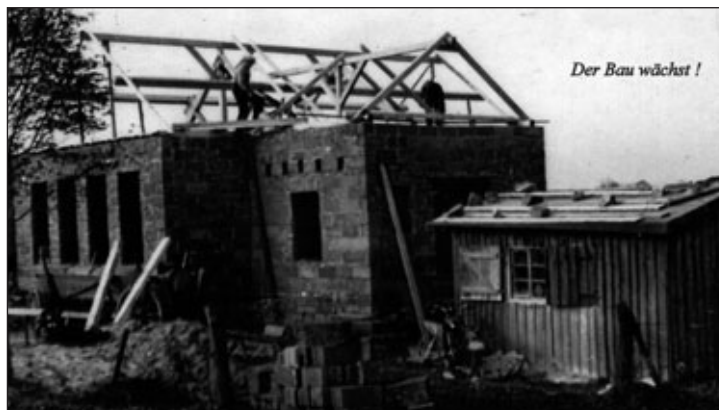
1955: Der Bau wächst!
