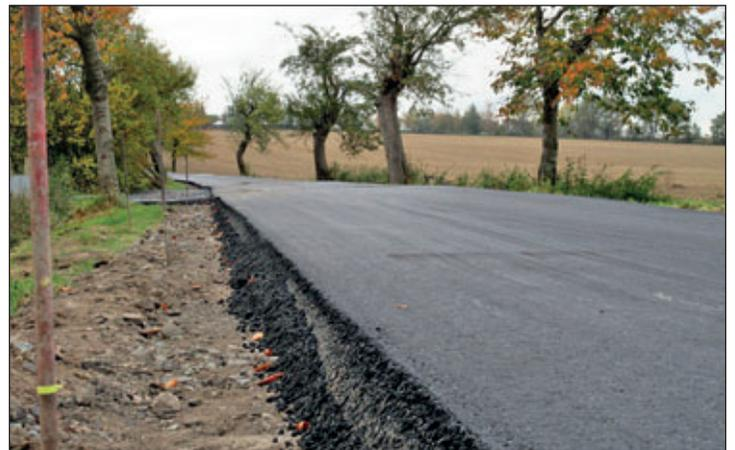
Diese Aufnahme verdeutlicht, dass hier nicht nur eine Reparatur durchgeführt wurde, sondern vielmehr mit Untergrundstabilisierung sowie mehrlagigem Bitumenaufrag eine haltbare Lösung zur Ausführung kam. Die vollständige Abbindung des Straßenbelages ist die Voraussetzung dafür, dass im kommenden Frühjahr noch die abschließenden Fahrbahnmarkierungen aufgebracht werden können.
