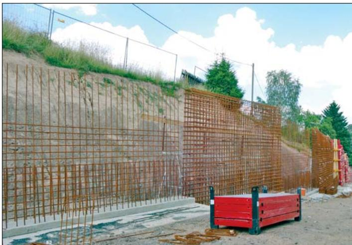
Beim Ausbau der Ortsdurchfahrt in Pappendorf werden mehrere Stützwände errichtet. Dieses Foto entstand am 6. Juli 2014 und zeigt für die Einschalung vorbereitete Eisengeflechte zur zukünftigen Hangsicherung.
