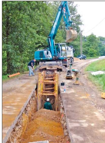
Mitarbeiter der Firma LFT aus Ostrau arbeiten in der Marbacher Hauptstraße am Aufbau der zentralen Abwasserentsorgung und verlegen dabei Rohrleitungen in einer Tiefe von fast fünf Metern.
