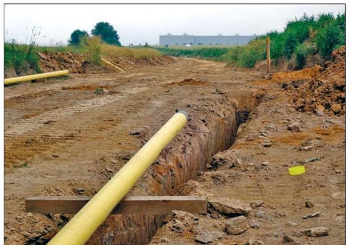
Die Verlegung der neuen Gashochdruckleitung sowie der Mittelspannungsleitungen für Elektroenergie von der Ortslage Etzdorf bis ins Berbersdorfer Gewerbegebiet sind fast abgeschlossen.
