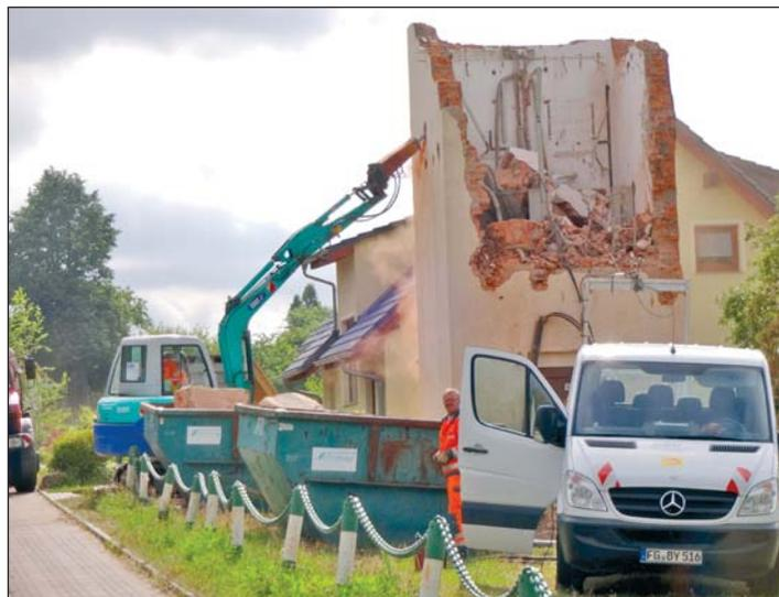
An der Marbacher Straße in Berbersdorf wurde im Auftrag der Mitnetz Strom diese ehemalige Trafostation abgerissen und durch eine kleinere Kompaktstation ersetzt. Durch das gute Miteinander mit diesem Stromnetzbetreiber sollte es auch in Zukunft gelingen, dass weitere Oberleitungen abgebaut und durch Erdleitungen ersetzt werden. Damit einhergehend sollen auch möglichst weitere alte Trafostationen abgerissen und durch neue ersetzt werden.
