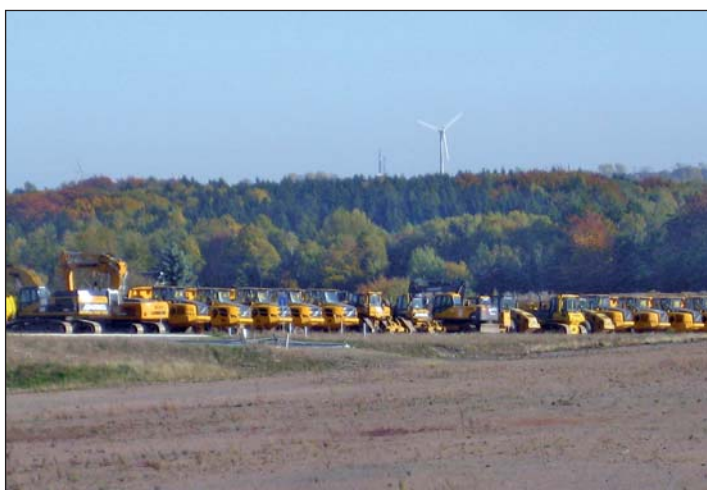
Schwere Technik der Arbeitsgemeinschaft der Firmen Tesch aus Schkeuditz und Amand aus Wilsdruff steht derzeit am Berbersdorfer Gewerbegebiet bereit, damit weitere Geländeregulierungsarbeiten erfolgen können.
