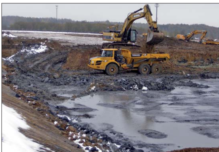
Der für die Jahreszeit untypische erste Schneefall erschwerte die Bauarbeiten. Diese Aufnahme vom 30. Oktober 2012 zeigt den Fortgang der Geländeregulierungsarbeiten im Baufeld II trotz Witterungsunbilden.
