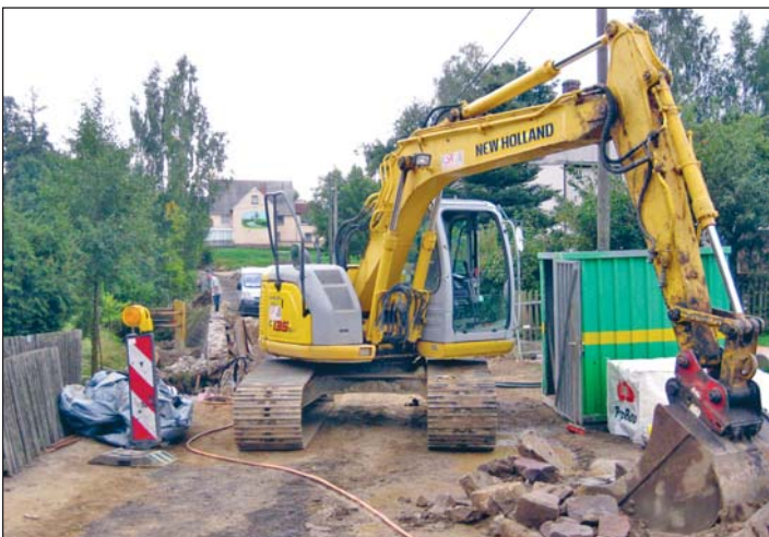
Schwere Technik ist derzeit beim Ausbau der Ortslage Marbach im Einsatz.
