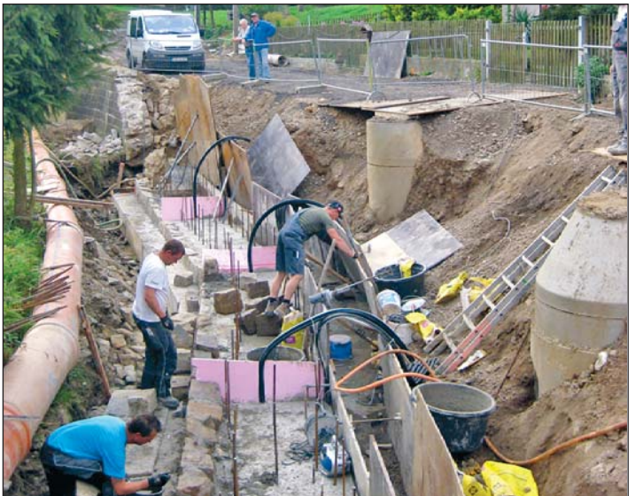
Diese Bauleute arbeiten im Auftrag der Firma Strabau aus Meißen an einer teilweise neu zu errichtenden Stützmauer zum Marienbach in der Ortslage Marbach.
