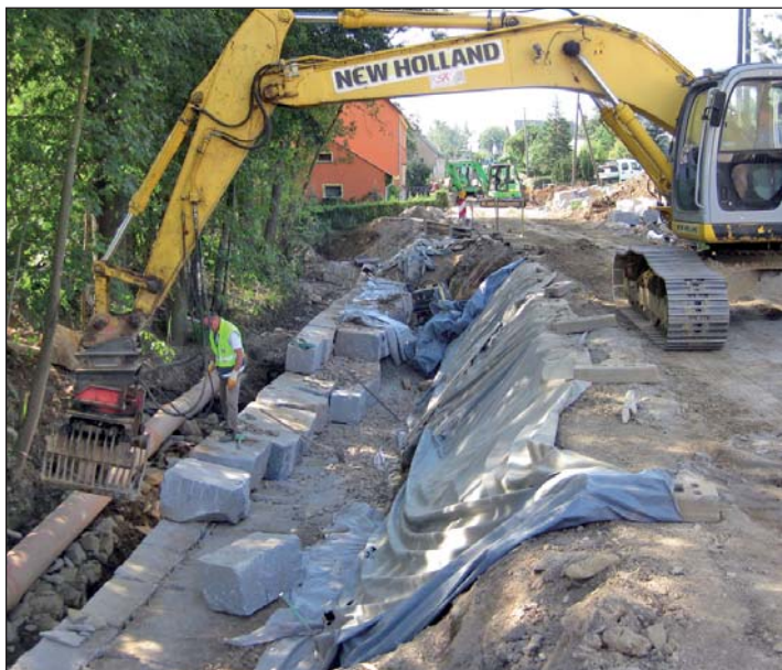
Mitarbeiter der Firma strabau GmbH Meißen versetzen hier mit schwerer Technik am 15. August 2012 Granitquader im Bereich der Hauptstraße 78.
