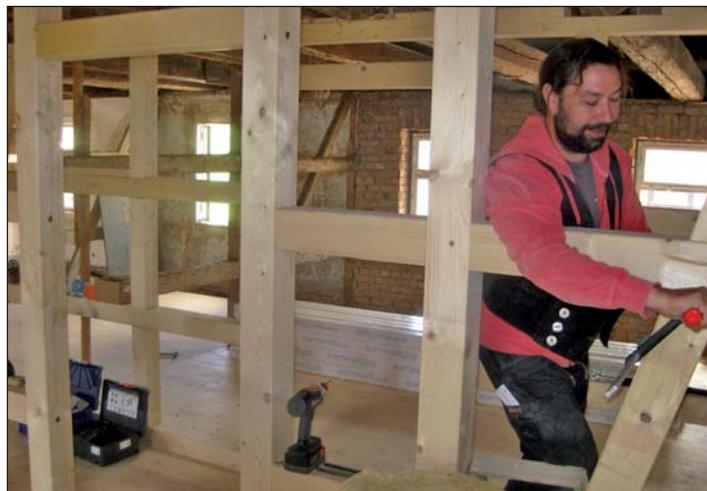
Zimmermann Torsten Haft aus Berbersdorf ist einer der Handwerker aus der Region, der im größeren Umfang an dem Mühlenausbauprojekt mitarbeitet. Mit viel Liebe zum Handwerk werden hier Fachwerkwände restauriert und gegebenenfalls neu hergestellt. So wird das Gebäude von unten nach oben, sozusagen von Etage zu Etage, komplett neu ausgebaut.
