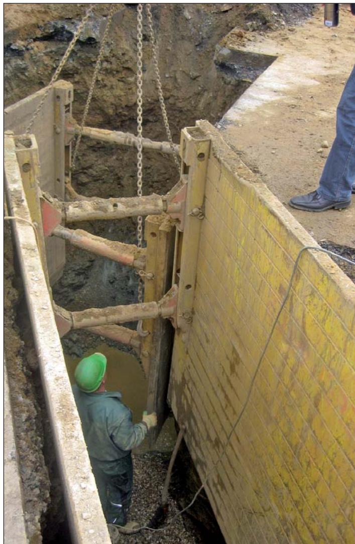
Mitarbeiter der Firma LFT aus Ostrau setzten Bauteile in der Straße am Marbacher Rosental ein, um in einer Tiefe von bis zu vier Metern hier die Freispiegelleitungen für die zentrale Abwasserentsorgung des Ortes verlegen zu können.
