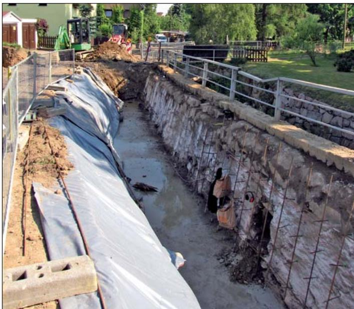
Die Statik dieser Stützwand bereitete einige Zeit Probleme. Mittlerweile wurde das Bauwerk mit Metallankern und Betonhinterfüllung ausgebaut. Nach dem Aufbringen der Bitumentragschicht der Fahrbahn werden die Brückenkappen aufbetoniert und ein neues Geländer wird für Sicherheit sorgen.
