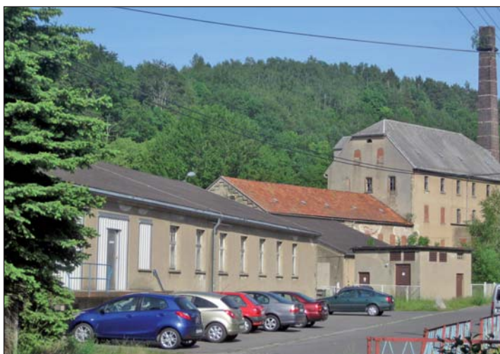
Diese Ansicht vom Mai 2011 zeigt die Industriebrache von der Waldstraße aus. Der einstige Betrieb entstand unter Nutzung der Wasserkraft der Striegis.
