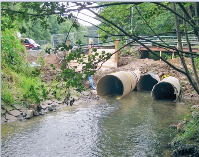
Das Wasser der Großen Striegis wird während des Brückenbaues durch diese Rohre umgeleitet.
