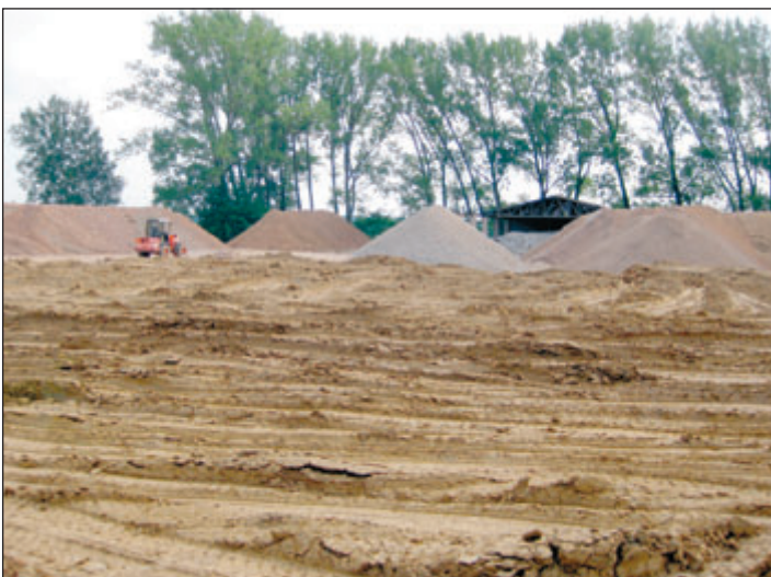
Auf dem Gelände der ehemaligen Schamotte in Naundorf beseitigt die Firma Chemnitzer Verkehrsbau die Schuttberge, recycelt das Abrissmaterial und ebnet das Gelände ein.
