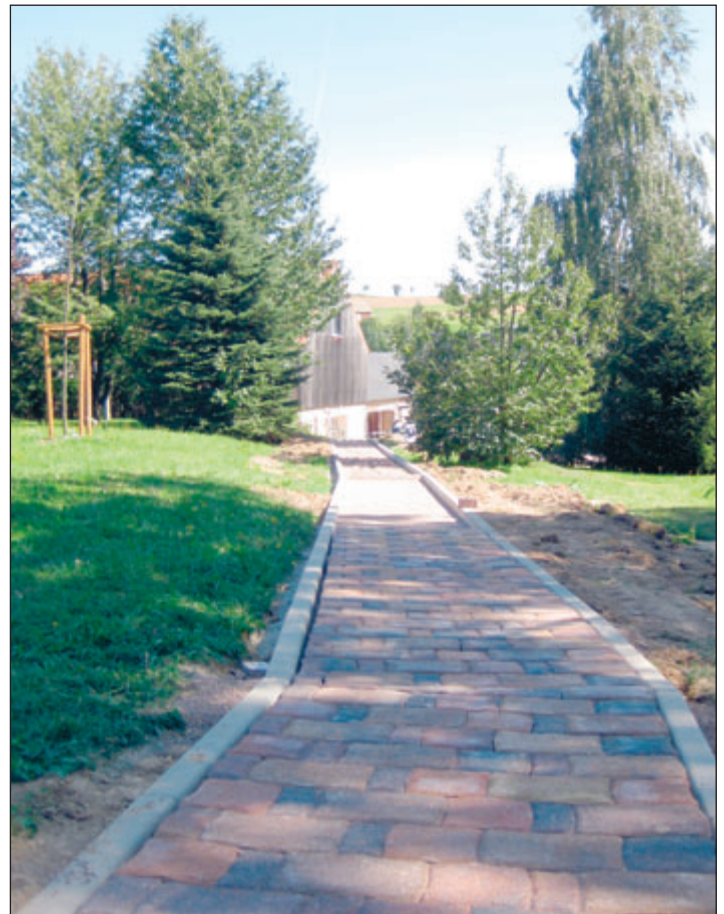
Der Weg zwischen Turnhalle und Dorfmitte in Marbach wurde durch Mitarbeiter des Bauhofes neu gepflastert. Damit ist dieser viel genutzte Weg wieder in einem ordentlichen Zustand.
