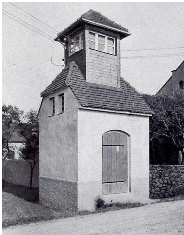
Die Abbildung zeigt eine sogenannte Gröbaer Trafostation, von denen drei in Pappendorf standen: bei Kippke, am Sportplatz und bei Schurichts.
