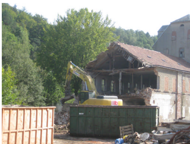
Der Abbruch schreitet voran.
