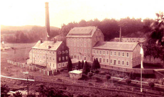
Der Betrieb nach der Errichtung der Neubauten (rechtes Gebäude) um 1940
