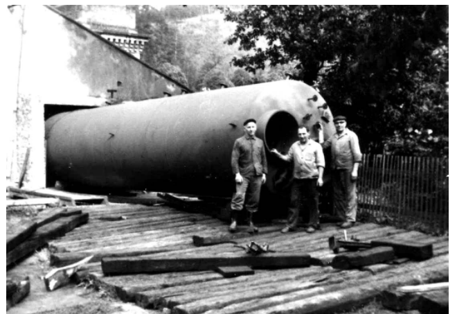
Der neue Kessel wird eingebaut. Auf dem Bild von links Hans-Peter Rudelt, Friedrich Lehmann und Karl Weigel.
