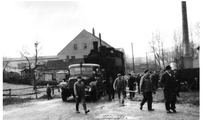
Der Schwerlasttransport – kurz vor der Ankunft im Betriebsgelände.
