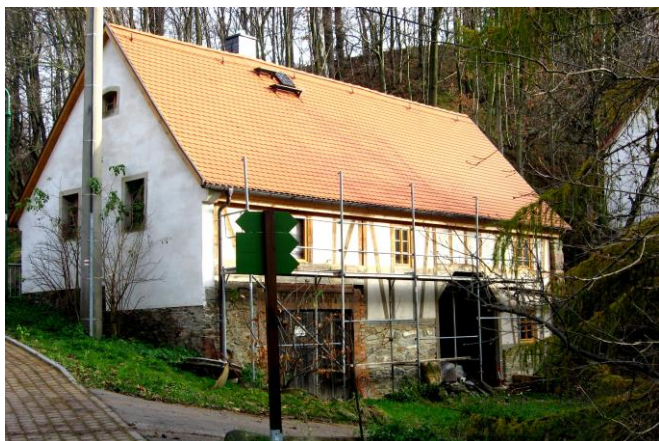
Die Scheune entsteht allmählich wieder in alter Schönheit.
