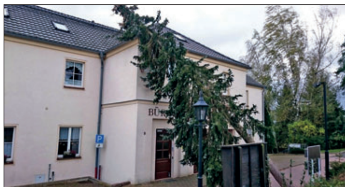
Diese Fichte wurde vor dem Gebäude der Berbersdorfer Kindertagesstätte entwurzelt und beschädigte das Dach des Gebäudes.
