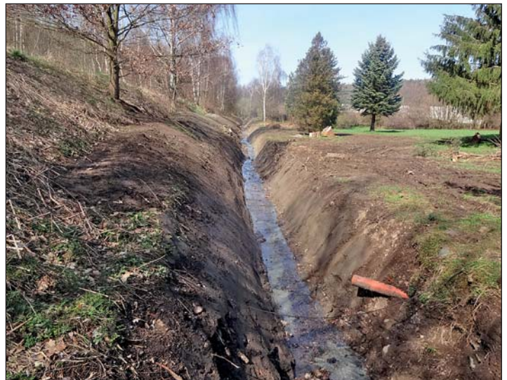
Im April dieses Jahres sind diese Arbeiten zum großen Teil abgeschlossen. Dabei musste mit äußerster Genauigkeit gearbeitet werden, da nur ein sehr geringes Gefälle im Dorfbach bis zur Einleitstelle in die Striegis vorhanden ist.
