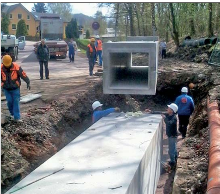
Im April dieses Jahres sind diese Arbeiten zum großen Teil abgeschlossen. Dabei musste mit äußerster Genauigkeit gearbeitet werden, da nur ein sehr geringes Gefälle im Dorfbach bis zur Einleitstelle in die Striegis vorhanden ist.
