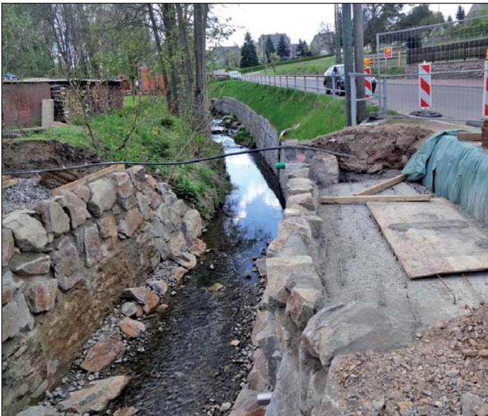
Hier sind die Widerlager des neuen Bauwerkes fertiggestellt.
