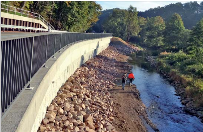
Entlang der Striegis wurde diese Stützmauer errichtet, die die aufliegende Kreisstraße trägt.
