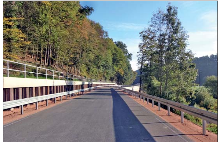
Fast das gesamte Bauvorhaben fand auf der Gemarkung des Striegistaler Ortsteiles Naundorf statt. Diese Aufnahme entstand mit Blick in Richtung Grunau am Tag der Fahrbahnmarkierungsarbeiten und zeigt, dass auch zur Absicherung des oberseitigen Hangbereiches eine massive Stützmauer errichtet wurde.
