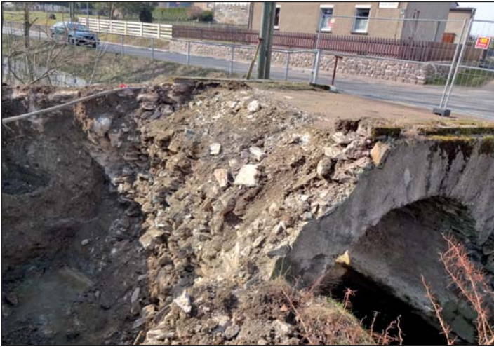
Mitte März 2015 hat der Abriss der maroden Brücke begonnen.
