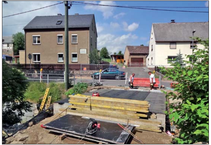
Der Überbau der neuen Brücke wurde in Betonbauweise eingebaut. Mitarbeiter der Firma CTI Connect – Tief- und Ingenieurbau GmbH aus Wildenfels bauen hier Granitborte zum Anschluss des neuen Bauwerkes an die Marbacher Hauptstraße ein.
