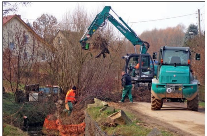
Am 8. März letzten Jahres erfolgten Arbeiten zur Baufeldfreimachung mit der Beseitigung von Fließhindernissen im Dorfbach und in den Randbereichen des Straßenkörpers.
