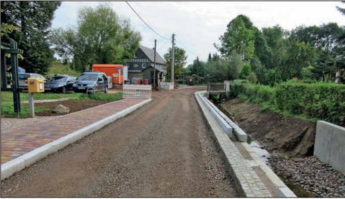
Am 20. September 2016 sind die Konturen der neu zu bauenden Straße „Am Dorfbach“ bereits gut zu erkennen. Borde und Pflasterstreifen waren zum Großteil gesetzt.
