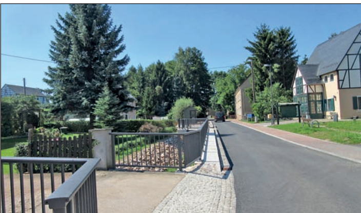
Am 23. August dieses Jahres erfolgte die Endabnahme der Straße „Am Dorfbach“ in Arnsdorf. Nach Montage der letzten Geländer erstrahlt der Ort in einem ganz neuen Licht.
