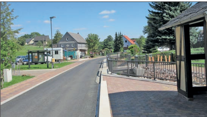
Aufgrund der teilweisen Neutrassierung der Straße musste die Bushaltestelle auf die andere Straßenseite gegenüber dem Bürgerhaus verlegt werden. Das Fachwerkgebäude fügt sich gut in das Ortsbild in Arnsdorf ein.
