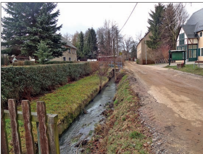
Ende Februar 2016 war die Fahrbahn aufgebrochen, so dass die Leitungsverlegungen beginnen konnten.
