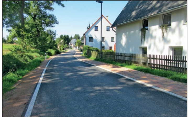
Die neu und grundhaft ausgebauten Straße „Am Dorfbach“ in Arnsdorf erhielt einen einseitigen Fußweg, der mit abgesenkter Bordkante im Begegnungsverkehr das problemlose Überfahren unter Berücksichtigung des Vorranges für Fußgänger ermöglicht.
