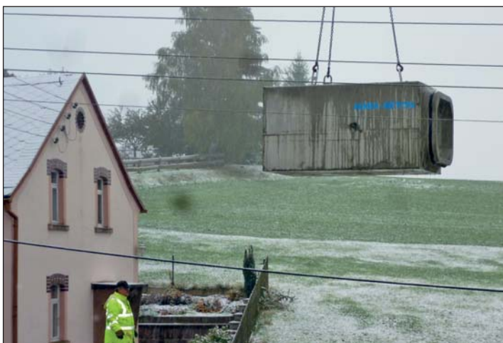
Diese Aufnahme entstand am 14. Oktober 2015 und zeigt den Einbau der neuen Bachquerungen, der bei leichtem Schneefall erfolgte.
