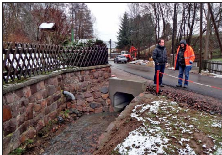
Anfang 2016 sind alle Querungen des Dorfbaches unter der Dittersdorfer Dorfstraße mit größeren Dimensionierungen eingebaut. In einem Teilbereich konnte bereits die über die Bachquerung führende bituminöse Tragschicht zur besseren Befahrung der Straßenabschnitte im Winter aufgebracht werden.
