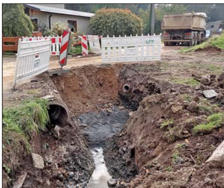
Gleich an drei Stellen quert der Dittersdorfer Dorfbach die Ortsstraße. Die beschädigten Verrohrungen konnten die darüber führenden Lasten nicht mehr tragen und mussten komplett erneuert werden.
