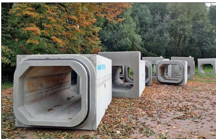
Im Herbst 2015 lagen die Betonteile für die neuen Bachquerungen in der Ortsmitte zum Einbau bereit.
