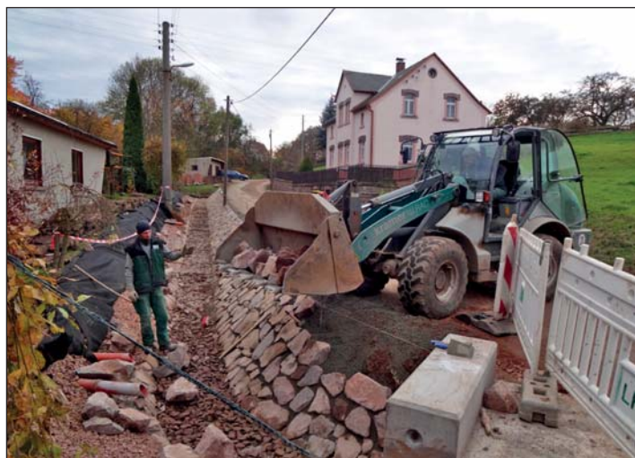
An die Querung angrenzende Bachbereiche konnten neu befestigt werden. Diese Aufnahme zeigt Mitarbeiter der Firma LFT Ostrau bei Arbeiten in Uferbereichen.
