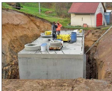
Mitte November letzten Jahres arbeiteten Mitarbeiter der Firma Gunter Hüttner aus Chemnitz an der Abdichtung des Löschwasserreservoirs.
