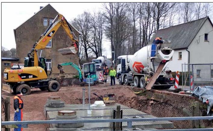
Diese Aufnahme entstand am 30. November letzten Jahres. Die Zisterne mit einem Fassungsvermögen von 96 Kubikmeter ist eingebaut und die Verfüll- und Erdarbeiten sind in vollem Gange.
