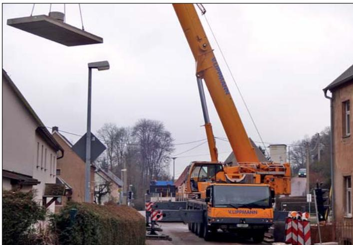
Mit schwerer Krantechnik werden die einzelnen Betonplatten über die Wohnhäuser an der Talstraße zum Einbaustandort befördert.
