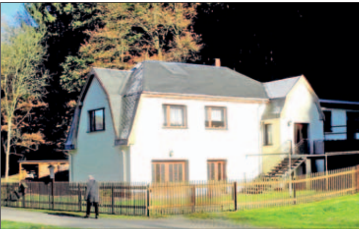
Das Turbinenhaus im Jahre 2016
