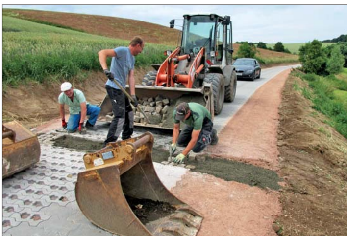
Mitarbeiter der Firma Walter Straßenbau KG aus Etzdorf bauten am 30. Juni 2016 mit Natursteinen Pflasterrinnen, die quer zur Fahrbahn zur Wasserabführung dienen sollen und gleichzeitig Nutzer der Straße dazu anhalten, die Geschwindigkeit zu reduzieren.
