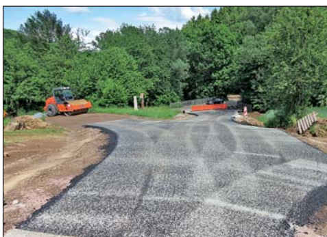
Am 1. Juni dieses Jahres bringen Mitarbeiter der Firma Walter Straßenbau KG aus Etzdorf auf dem innerörtlichen Bereich in Kummersheim die bituminöse Deckschicht der Fahrbahn auf.
