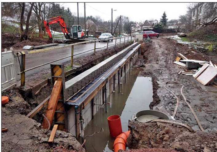
Im Februar 2016 war die neue Stützmauer bereits in Betonbauweise im Entstehen.
