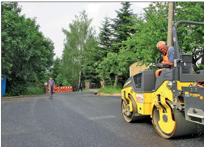
Am 1. Juni dieses Jahres bringen Mitarbeiter der Firma Walter Straßenbau KG aus Etzdorf auf dem innerörtlichen Bereich in Kummersheim die bituminöse Deckschicht der Fahrbahn auf.
