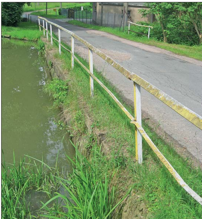
Die marode Stützmauer zwischen der Dorfstraße und dem Feuerlöschteich in der Ortsmitte wurde abgerissen und der Löschteich geschlämmt.
