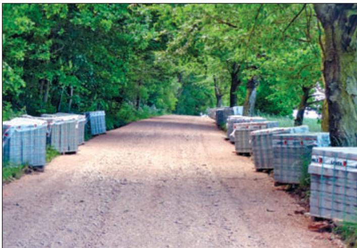
Nachdem eine Kalkstabilisierung auf der gesamten Strecke erfolgt ist, stehen hier am 11. Mai dieses Jahres bereits die für den landwirtschaftlichen Wegebau vorgefertigten Betonsteine zum Einbau auf Paletten bereit.
