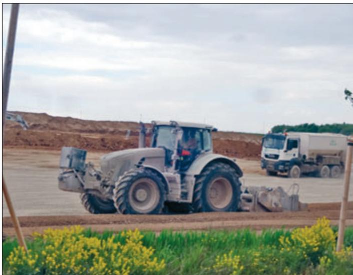
*Damit das begradigte Baufeld die notwendige Tragfähigkeit erhält, werden in einem nächsten Arbeitsschritt Kalkstabilisierungen durchgeführt.*
